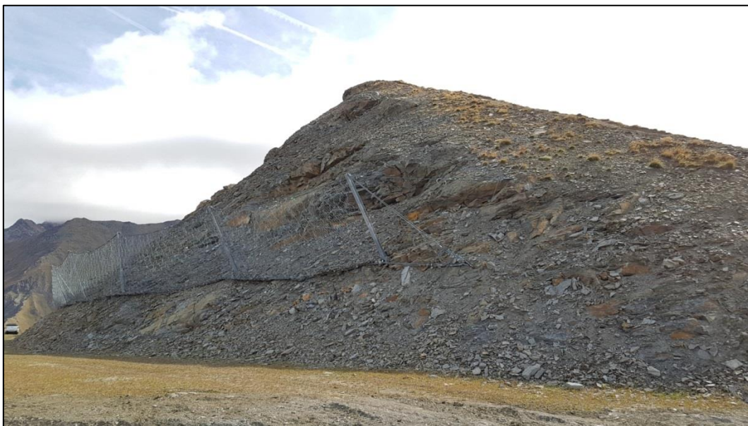
Figura 33 – Vista del tratto di versante settentrionale della Platta de Grevon (lato Pila) a monte della pista da sci con localizzazione delle opere di protezione passiva.
